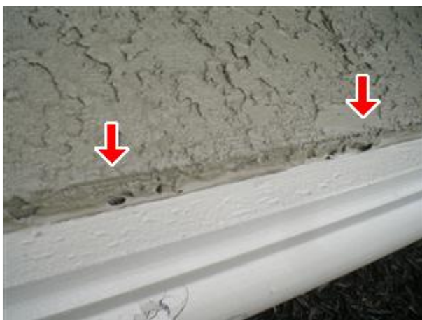
2.0 Picture 10 re-caulk bottom edge
